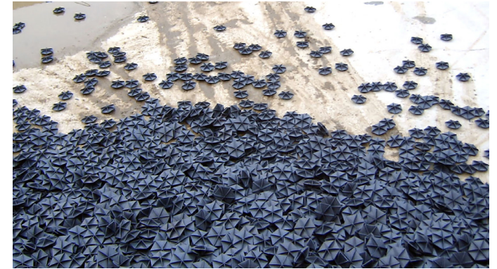
También instalación en tanque vacío
