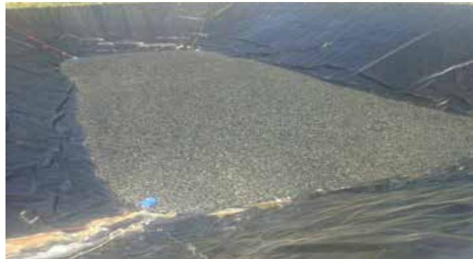
*Basado en lo anterior, escogimos para cubrir la balsa, la cubierta flotante Hexa-Cover®. Esta solución ofrece todas las características requeridas. Después de la instalación hemos visto una reducción importante de la evaporación de alrededor de un 75- 80% que representa un ahorro extra de agua para nosotros.*
